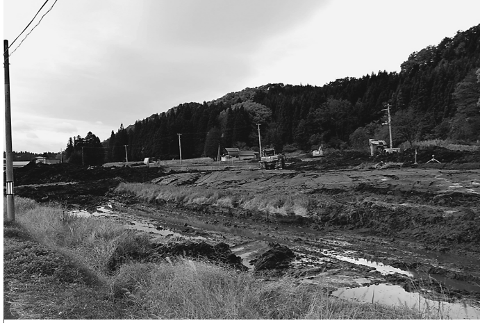
紫波地区で第1号工事が着工した
